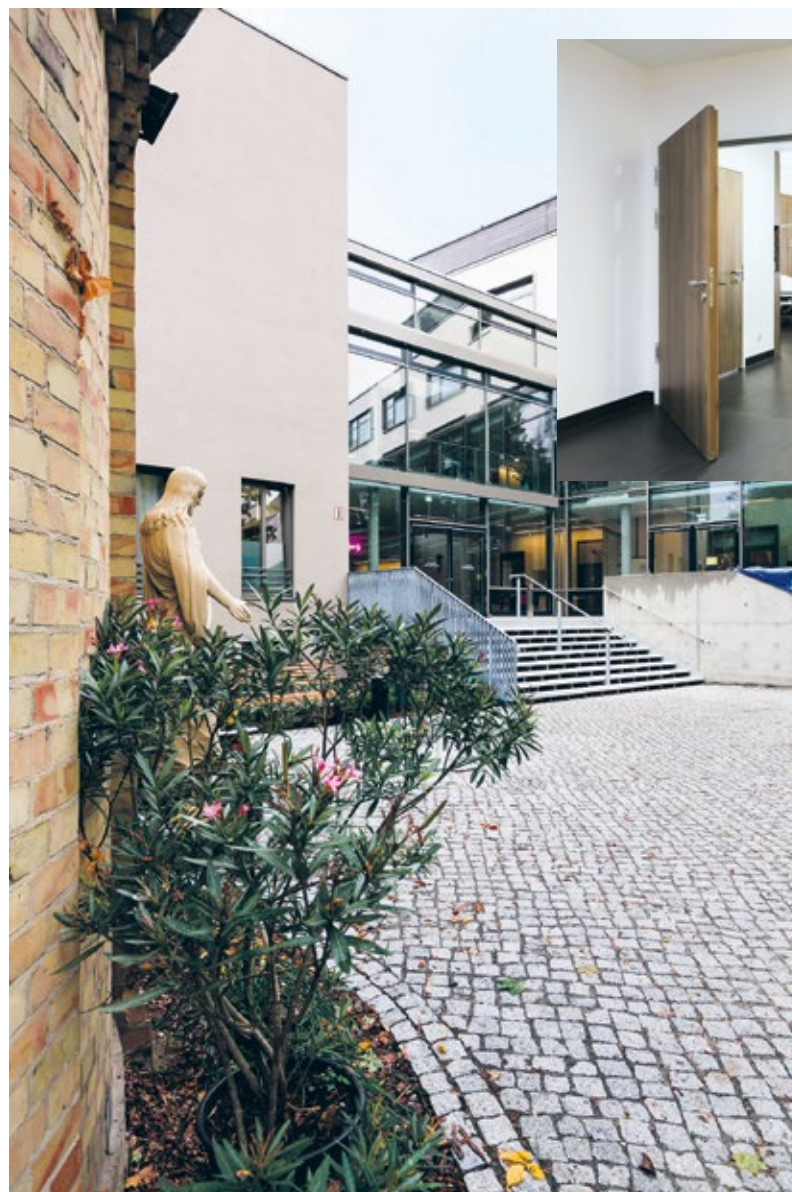
St. Josefs-Klinikum Potsdam, Eingangsbereich Neubau
