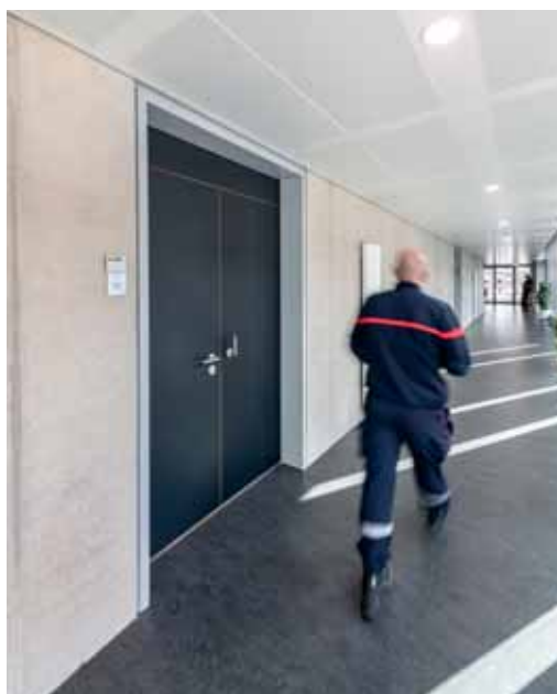
Die Brandschutztüren genügen hohen Anforderungen an Brand- und Rauchschutz. 2-flügelige Tür zum Konferenzsaal in kontrastreichem Design. Zugang zur Haupttreppe.
